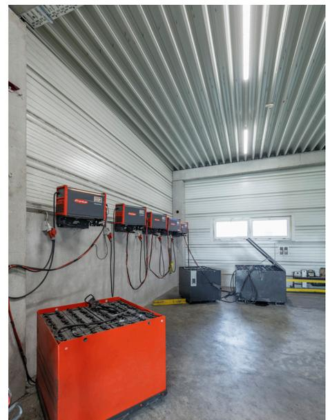
Einsatzzeiten über Wechselbatterien. Die in der Vergangenheit eingesetzten Hochfrequenz (HF)-Ladegeräte sorgten jedoch für gewaltige Probleme. Lastspitzen, die beim gleichzeitigen Laden der Stapler auftraten, verursachten starke Frequenzstörungen im Stromnetz – und diese führten dazu, dass die IT regelmäßig abstürzte. Das Ergebnis waren erhebliche Einschränkungen im Betriebsablauf und unnötige Kosten.
